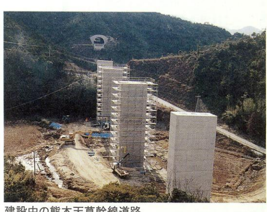
建設中の熊本天草幹線道路
