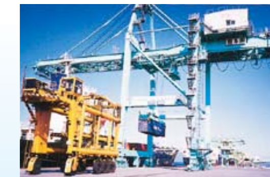
ガントリークレーン
