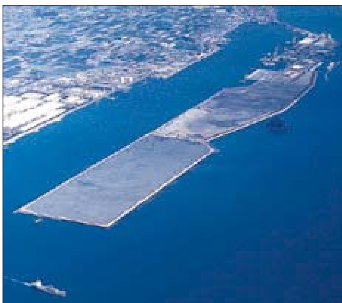
八代港 加賀島地区 土砂処分場
