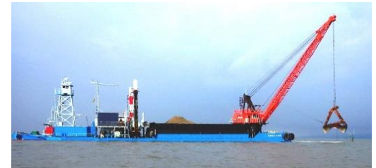
覆砂工事状況(R6.5 荒尾市)
