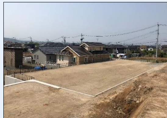
造成工事一部完了（宮園地区）
