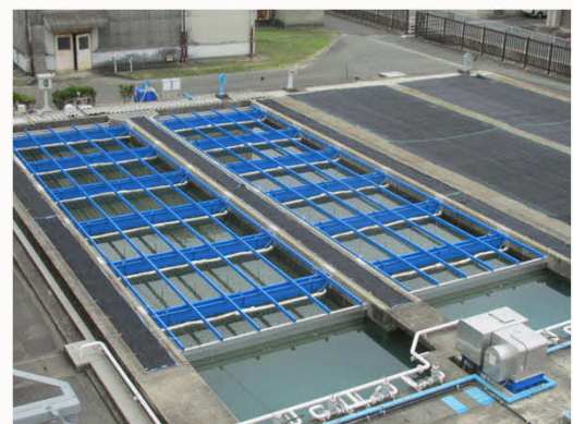
傾斜管沈降装置(上向流式)
