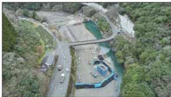
新神屋敷橋下部工の施工状況
