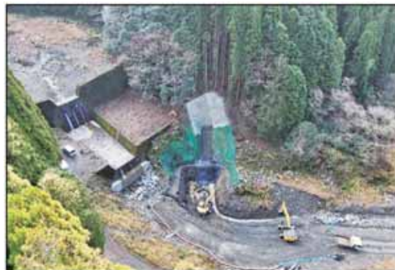
横手谷川砂防堰堤3の施工状況
