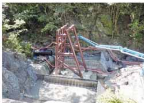
入鴨川第8砂防堰堤の施工状況
