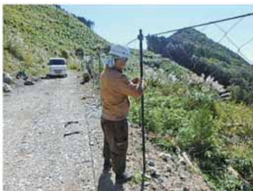
シカ防護柵の設置状況
