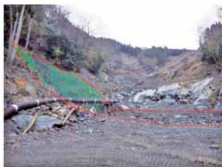
野々脇地区（施行中：床掘状況）
