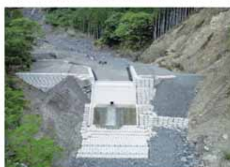
R4災害に対する緊急対策 （宮目木川仮砂防堰堤）
