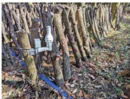
センサー設置状況
