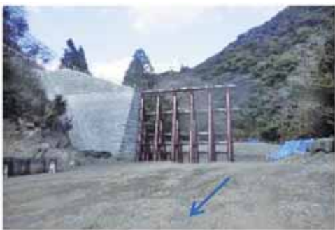
小川第2砂防堰堤工事の施工状況
