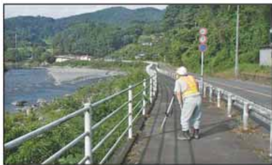
道路測量業務の状況
