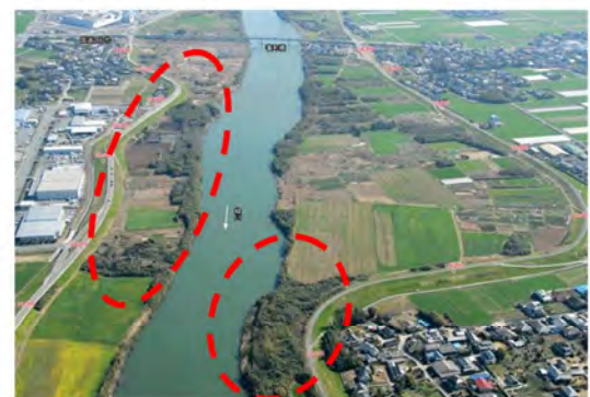
写真 4.3-15 河道内に繁茂する樹木の例
