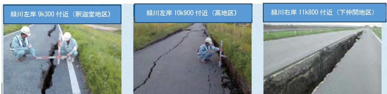
写真 2.1-7 緑川における緊急点検状況
