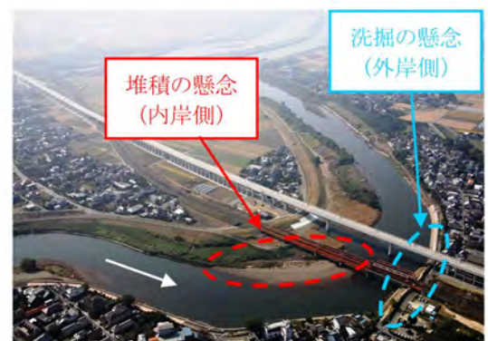
写真 4.3-16 湾曲部の河道管
