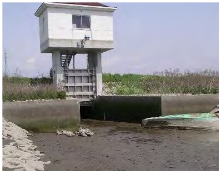
写真 2.1-14 樋管前面のガタ土堆積状況
