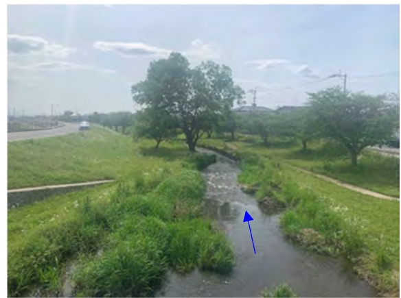
写真 2.3-46 上流部の秋津川河川公園付近
