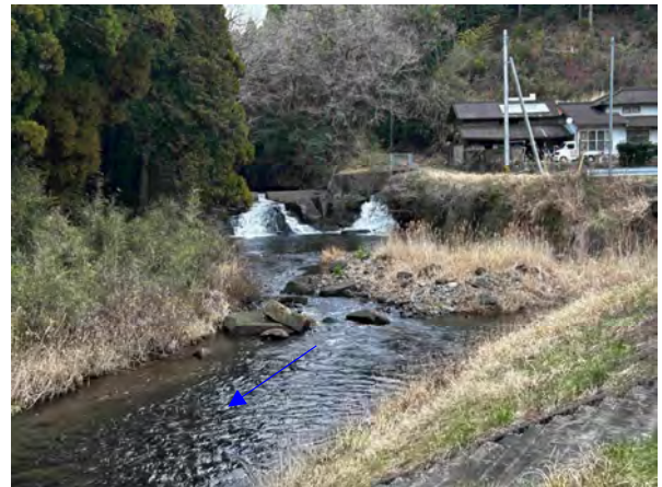
写真 2.3-58 五老滝川と黒木尾川合流部
