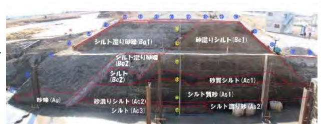
写真 2.1-1 加勢川右岸清正堤の断面状況
