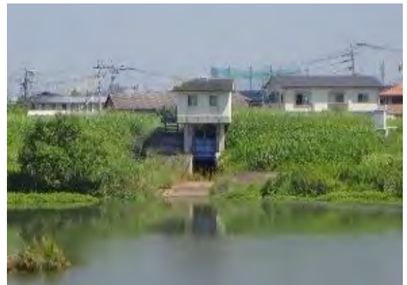
写真 4.2-10 瀬ノ江排水樋管
