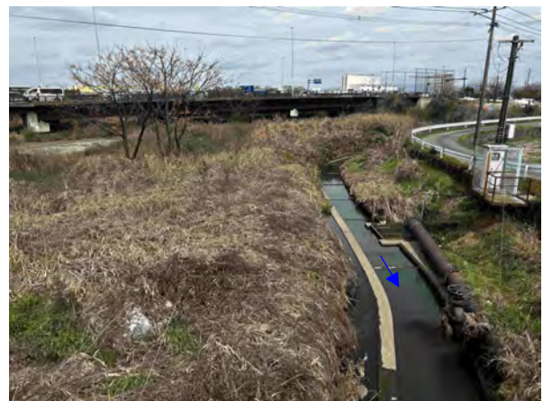
写真 2.3-28 天明新川上流端の三面コンクリート水路
