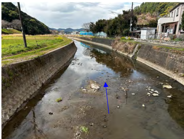
写真 2.3-31 浜戸川上流部の平瀬区間
