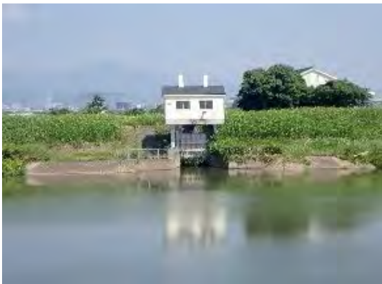
写真 4.2-9 画図第二排水樋管
