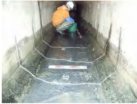
写真 2.1-13 樋管のクラック発生状況
