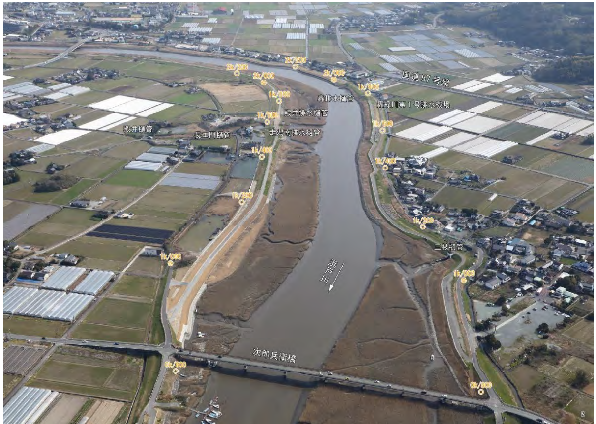
写真 4.2-4 次郎兵衛橋上流付近（緑川 1k0 付近）
