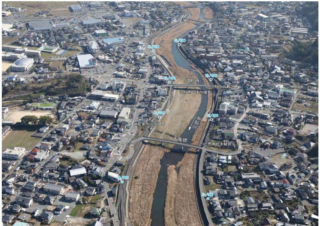
写真 4.2-6 五庵橋付近（御船川 5k2 付近）
