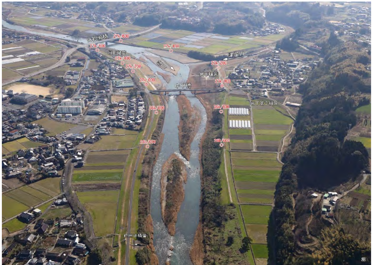
写真 4.2-1 中甲橋付近（緑川 27k0 付近）
