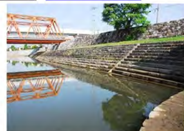
工事完了後の船着き場
