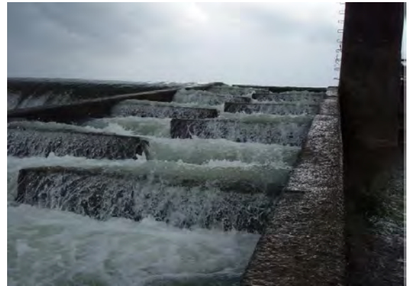
写真 4.2-8 築地堰の魚道
