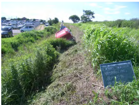
写真 4.3-3 堤防除草作業
