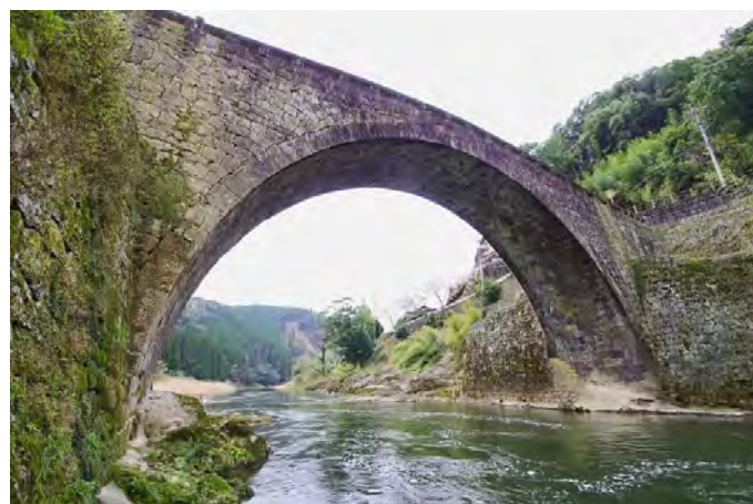
写真 1.1-26 霊台橋（美里町）
