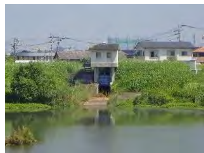
写真 2.3-65 瀬ノ江排水樋管(加勢川 9k000)
