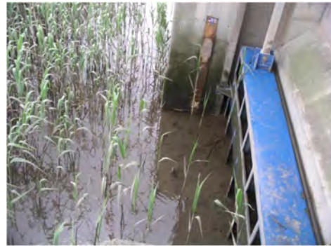
写真 2.1-14 樋管前面のガタ土堆積状況
