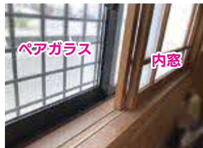
リフォーム時に ペアガラスと内窓にした例
