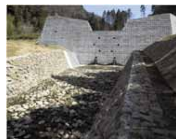
自然石利用護岸工
