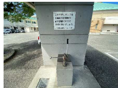
防災井戸の写真（菊池市道の駅）
