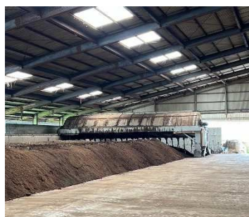
家畜排せつ物堆肥化施設
