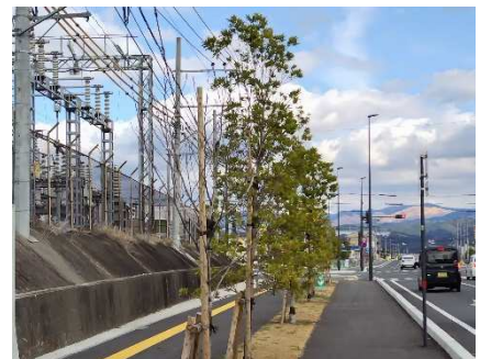
（都）益城中央線 植栽状況
