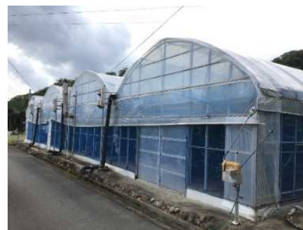
不知火類の加温ハウス
