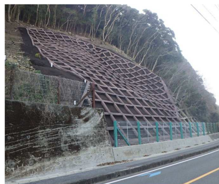
道路防災事業：国道 389 号（苓北町）
