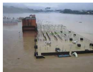
浸水した下水処理場（人吉市）
