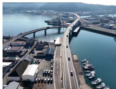
道路改築事業：国道324号(本渡道路)
