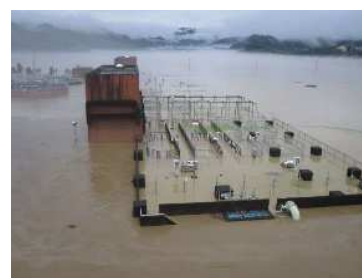
浸水した下水処理場（人吉市）
