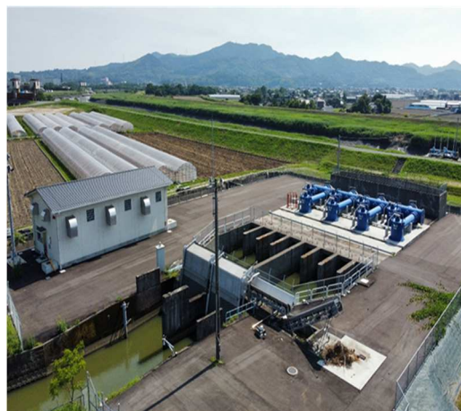
碓江排水機場（熊本市）
