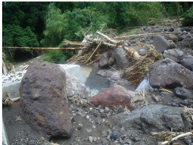
塩井川砂防堰堤堆砂敷袖部(7/15撮影)
