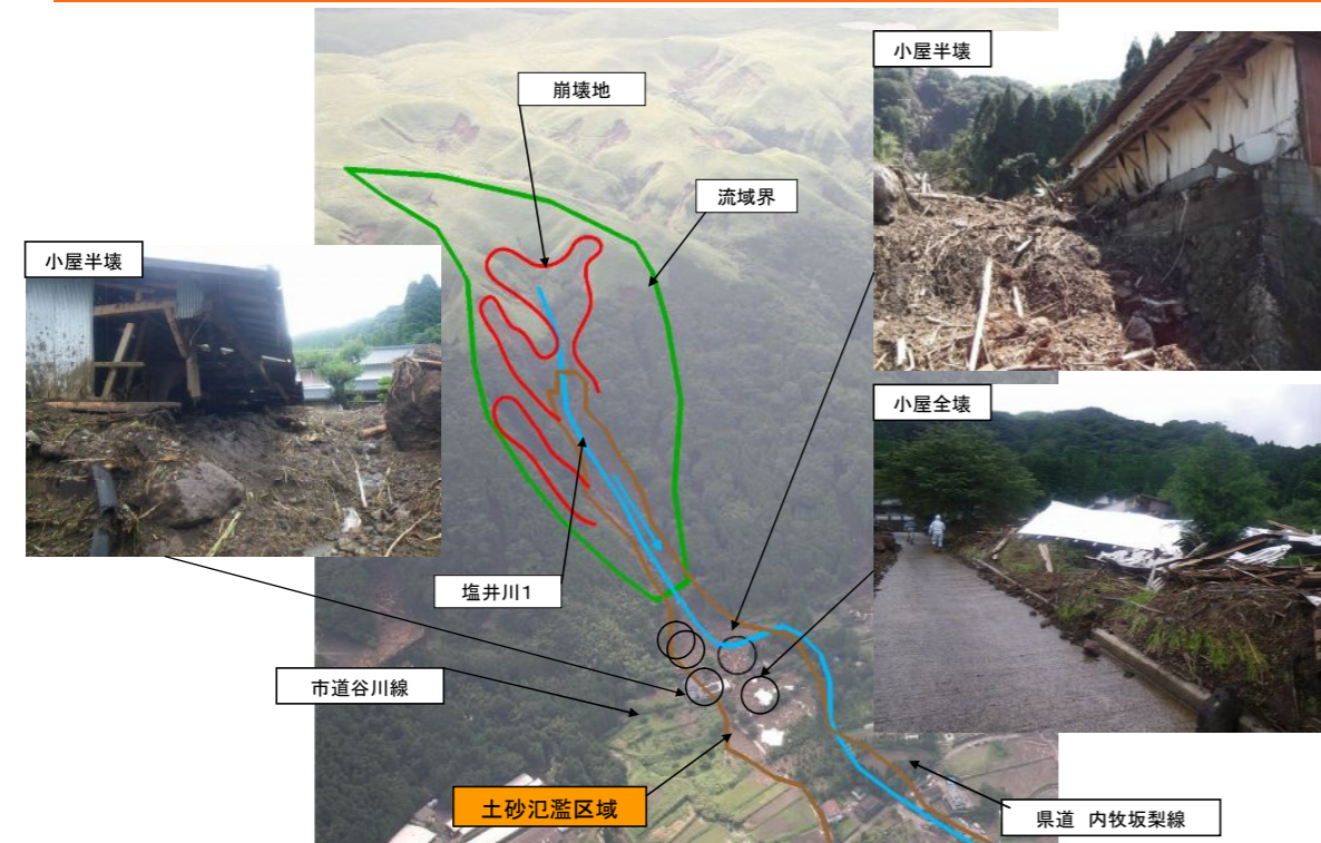
7月12日発生 土石流災害 塩井川1 (熊本県阿蘇市一の宮塩井)
