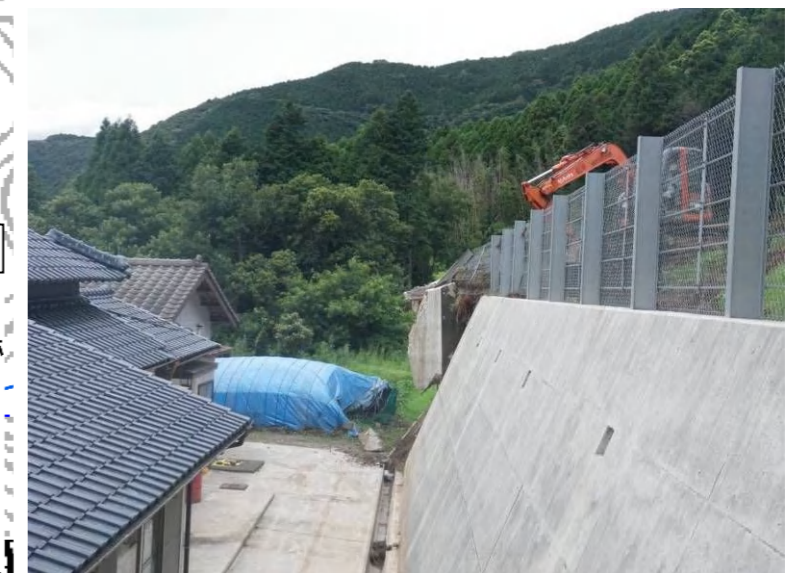
写真. 崩壊地末端における待受擁壁の状況(図中②)
