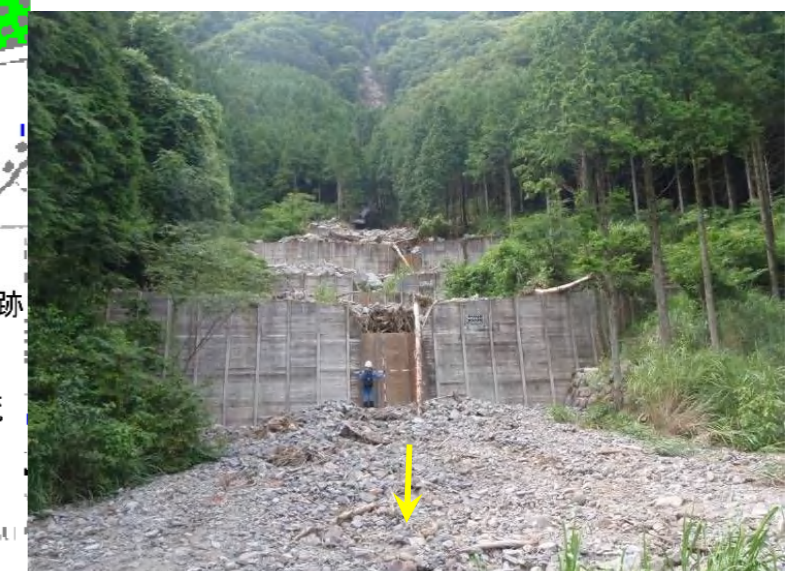
写真. 谷止工による土砂・流木の捕捉状況
