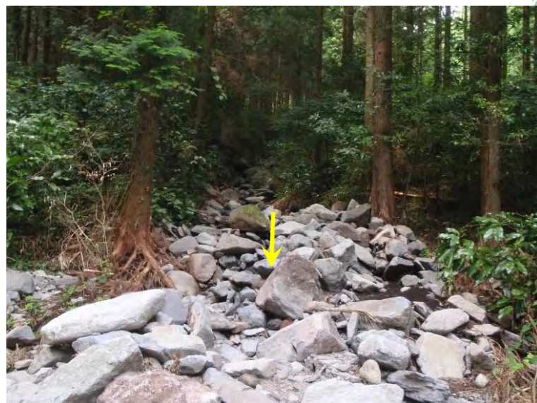
写真. 谷止め工下流の河道
