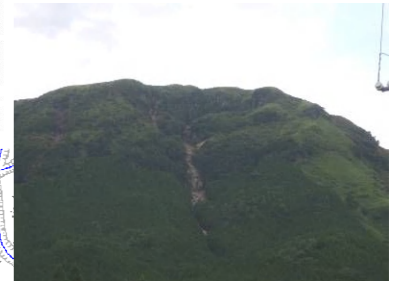
写真. 崩壊地源頭部遠景
