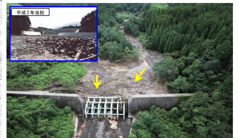
写真. 古恵川 9号堰堤における土砂・流木捕捉状況
