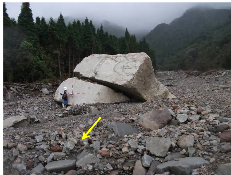
写真. 既往対策施設の破損状況(图中①)
