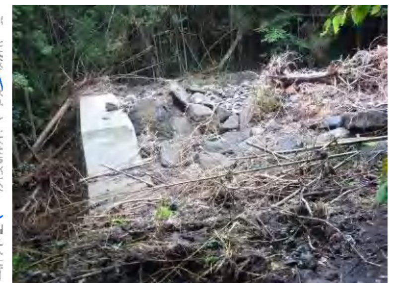
写真. 中流域の治山谷止工における土砂・流木捕捉状況
