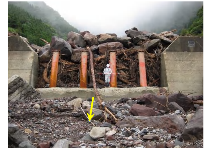
写真. 鋼製砂防堰堤における土砂・流木捕捉状況
