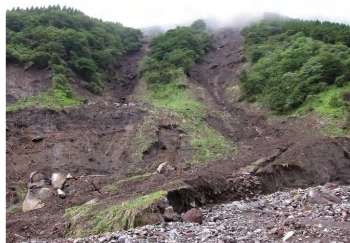
写真. 源頭部の崩壊状況
