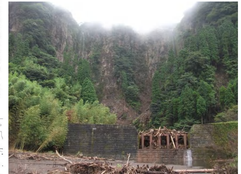
写真. 源頭部及び古閑の滝砂防堰堤の流木捕捉状況
