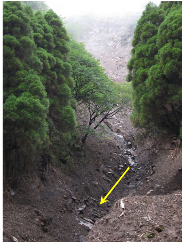
写真. 溪床の侵食状況
