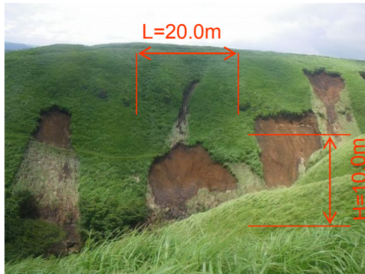
写真. 上流部の侵食状況
