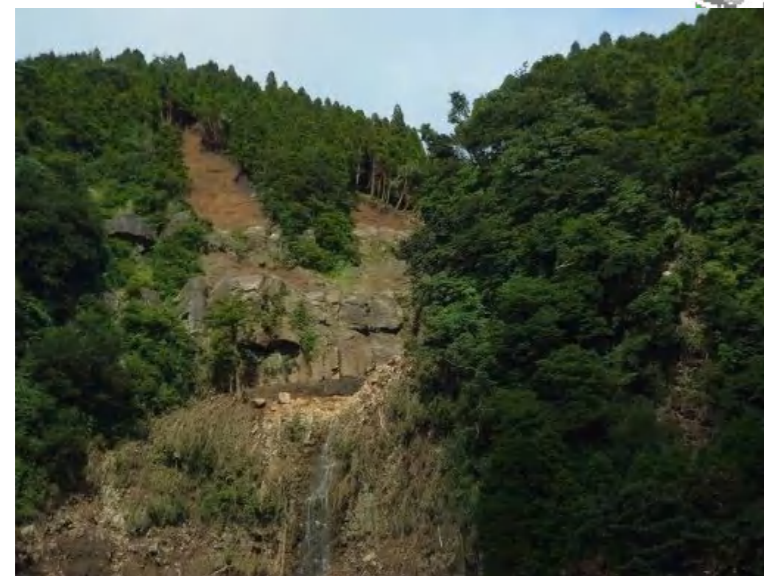
写真. 源頭部の崩壊状況
