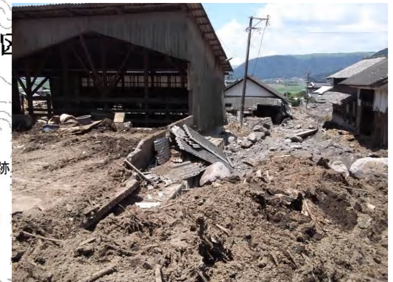
写真. 家屋の被害状況
