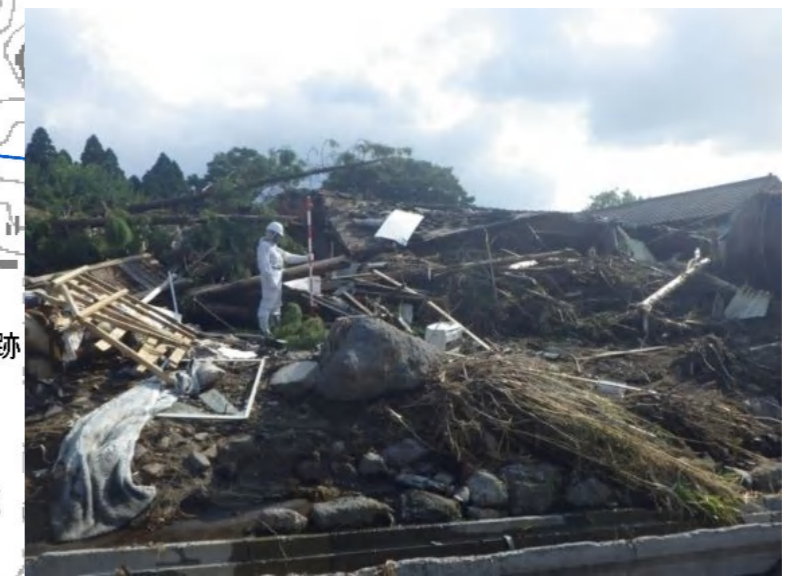
写真. 家屋の被害状況
