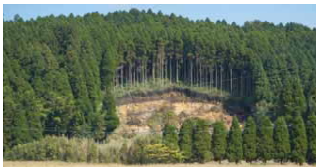
写真 5.3 丘陵地の降下火砕物斜面の崩壊事例(三久保地区)(写真 3.3 再掲)
