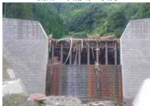
写真 3.19 仮川砂防堰堤の土砂・流木捕捉状況
