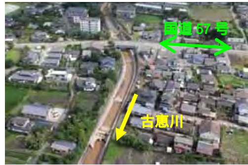
写真 3.24 国道57号松原橋の周辺状況(平成24年災害後)
