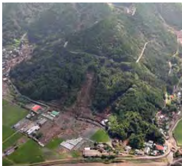
写真 3.2 崖錐斜面の崩壊事例(手野地区)
