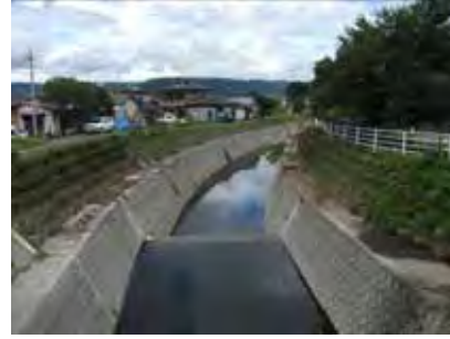
写真 3.22 国道57号松原橋周辺の渓流保全工の状況(平成24年災害後)
