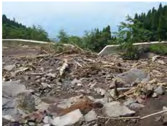
写真 3.7 黒川第4支流における治山谷止工の土砂・流木捕捉状況(上流より撮影)
