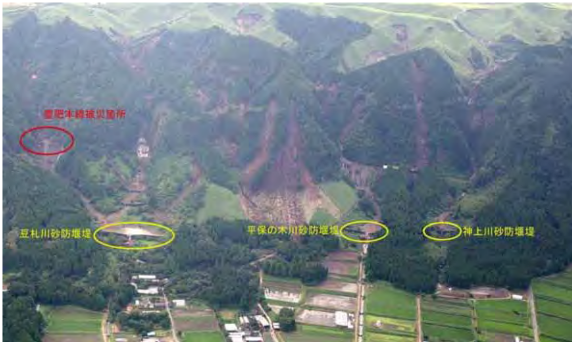
写真 3.20 豆札川、平保の木川、神上川における既設砂防堰堤の土砂捕捉状況
