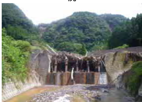
写真 3.14 平保の木川砂防堰堤の土砂・流木捕捉状況
