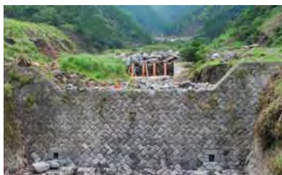
写真 3.11 根子岳南側斜面における治山谷止工の土砂捕捉状況
