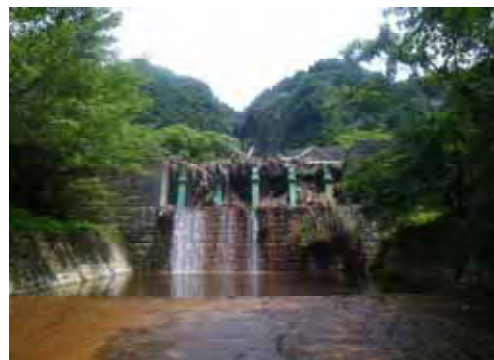
写真 3.13 豆札川砂防堰堤の流木捕捉状況
