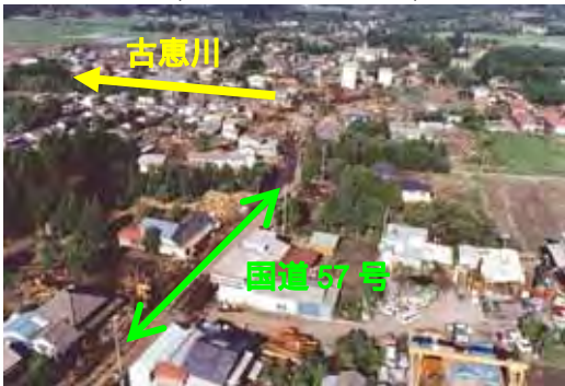
写真 3.23 国道57号松原橋の周辺の氾濫状況(平成2年災害後)
