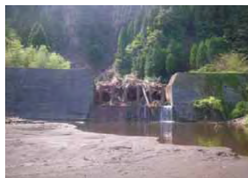
写真 3.15 古閑の滝砂防堰堤の土砂・流木捕捉状況
