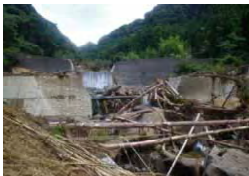
写真 3.16 八反田川砂防堰堤の土砂・流木捕捉状況(下流側より施設を望む)
