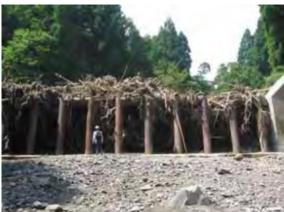
写真 3.8 黒川第4支流における鋼製堰堤の流木捕捉状況
