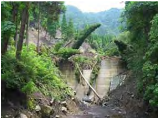
写真 3.6 黒川第4支流における治山谷止工の土砂・流木捕捉状況(下流より撮影)
