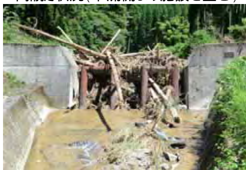
写真 3.18 赤鹿川砂防堰堤の土砂・流木捕捉状況
