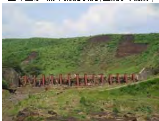
写真 3.9 東岳川本流における鋼製堰堤の土砂等捕捉状況
