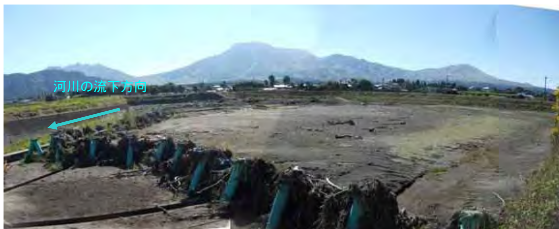
写真 3.27 黒川の多目的貯木池の流木捕捉状況
