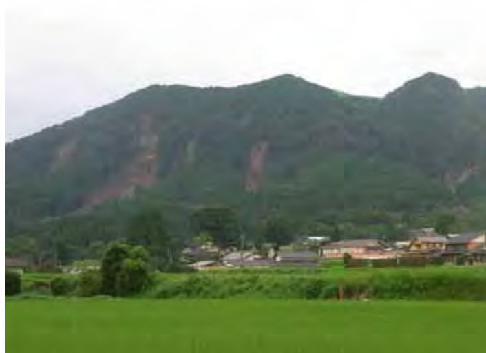
写真 1.9 卯の鼻(滝室坂付近)の状況(斜面中腹には阿蘇火砕流の溶結部が認められる)
