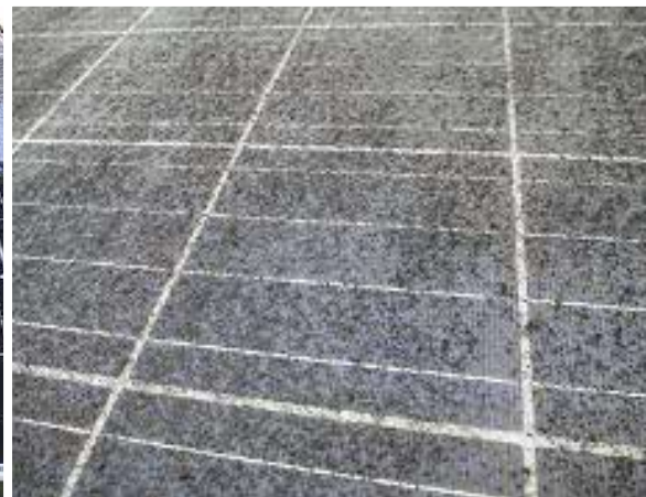
食品工場排気口（油汚れ）
