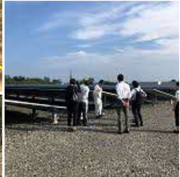
砂利で綺麗に整備 された発電所 (優良事例)
