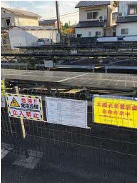
確実な明示とフェンス 法標識と立入禁止標識 (優良事例)
