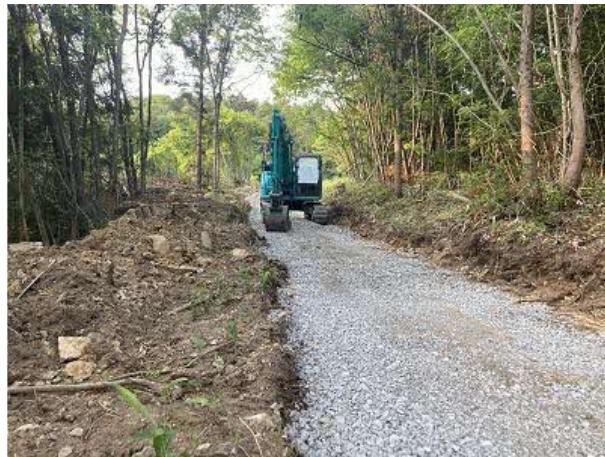
発電所進入路の整備も 大切な仕事
