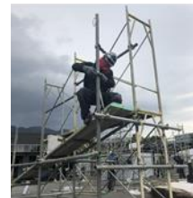
足場仮設工事
