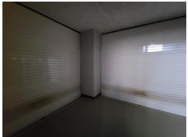
写真6 火災場所の防火シャッターが下りた様子
