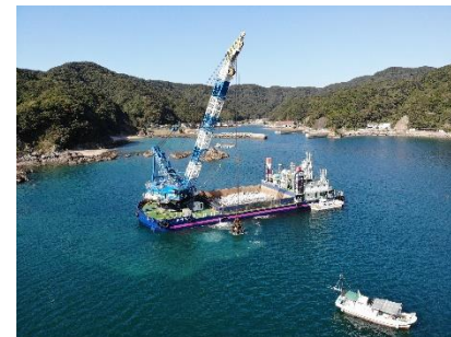
藻場造成工事(投石)状況 (天草市軍浦)
