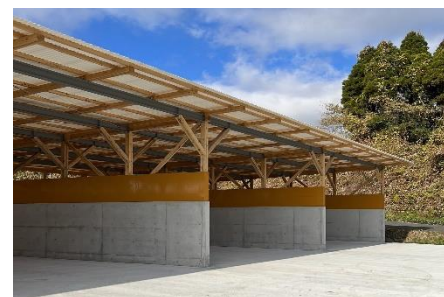
堆肥化処理施設
