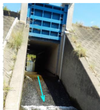
出水川排水樋管
