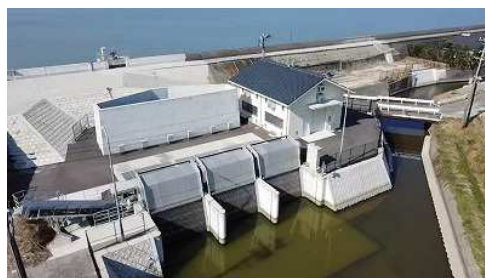
< 豊川中央排水機場（R3.7 月供用開始） >
