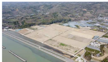
< 区画整理施工状況 (R5.4 末) >
