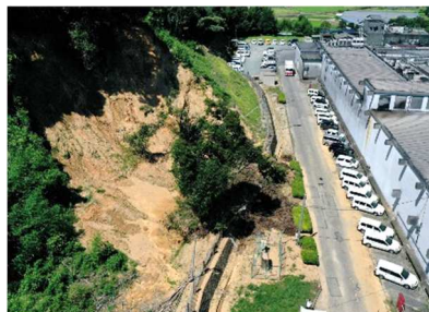
< R2.7月豪雨による山地災害の状況 >
