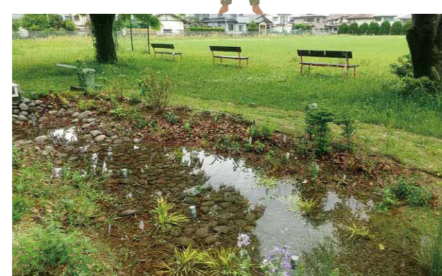
雨庭(屋根などに降った雨水を排水路に直接流さず、一時的に貯留し、地面に浸透させます)
