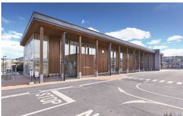
「南関町庁舎」(南関町)
