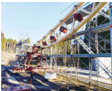
山都町体育館モックアップ強度試験
