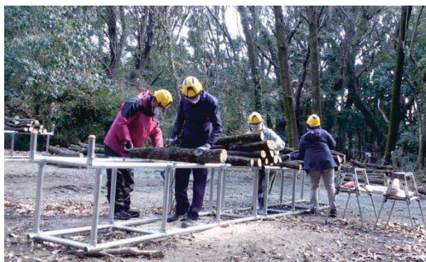
図-4 単管パイプを用いた簡易な作業台
