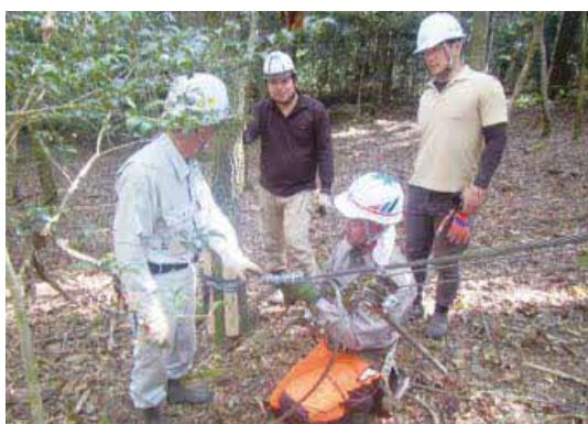
ワイヤロープ設置状況
