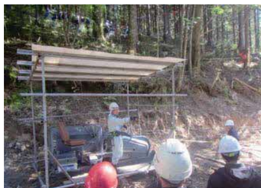
架線設置確認状況
