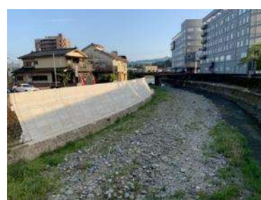
復旧状況（令和4年6月完了）
