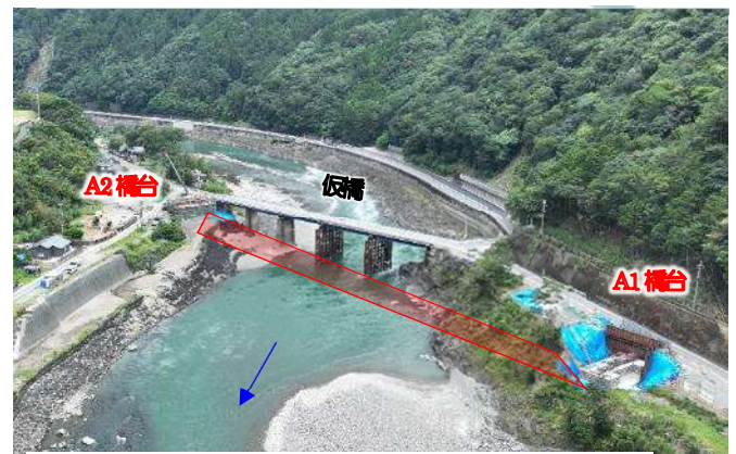
国道 219 号 鎌瀬橋施工状況 (令和 5 年 8 月)
