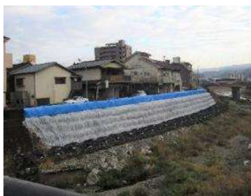
応急状況（令和3年5月時点）
