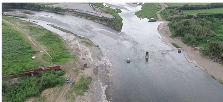
写真：「球磨川第4橋梁」付近(空撮)(流失した橋桁・橋脚等は撤去済み)
