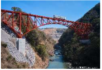
「南阿蘇鉄道」災害復旧工事完了
