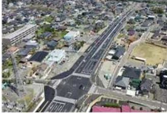
県道熊本高森線の4車線化
