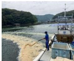
粘土の散布状況(ホースで散水後、スクリューで攪拌)
