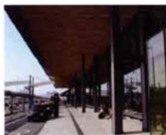
写真2 軒裏に使用された木材(月経くまもと空港) 軒裏は日当たりと雨掛りが少ないため、比較的(つくば市立東小学校)透明性の高い塗装でも劣化が緩やか。
