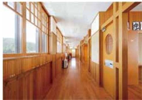
■学校廊下の木質化改修事例
