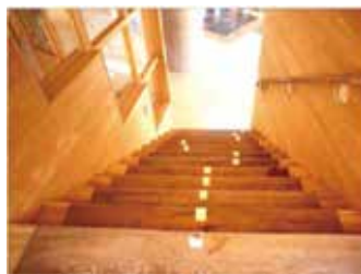
■旧建物の階段床板を再利用 した事例【思い出を伝える】
