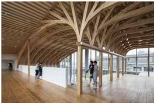
■混構造（鉄筋コンクリート造+木造） 山鹿市立山鹿小学校 オープンスペース 資料：シーラカンスK&H（株）HP より
