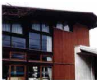
写真2 軒裏に使用された木材(月経くまもと空港) 軒裏は日当たりと雨掛りが少ないため、比較的(つくば市立東小学校)透明性の高い塗装でも劣化が緩やか。
