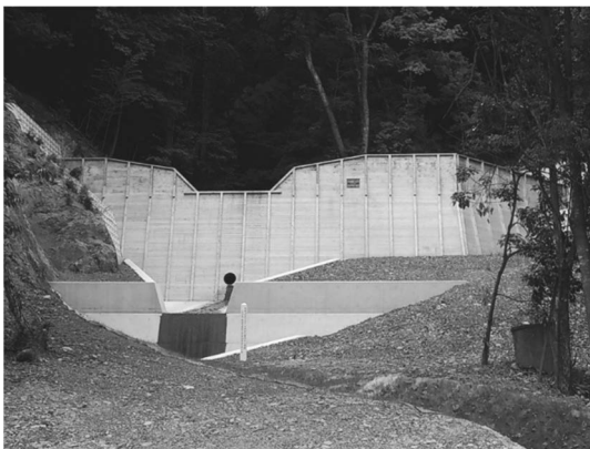
溪間工（谷止工）
