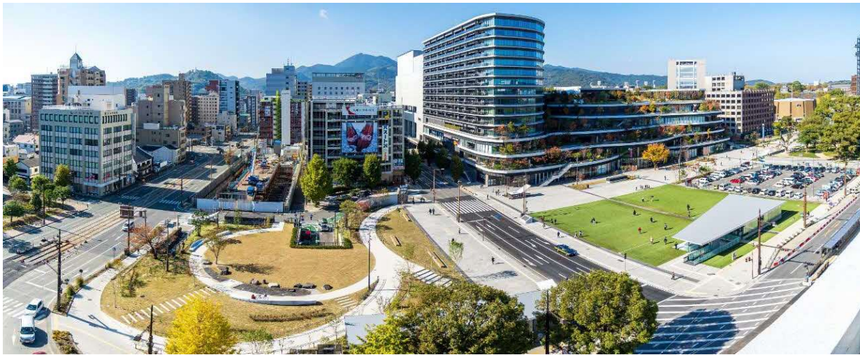
整備完了後のシンボルプロムナード
