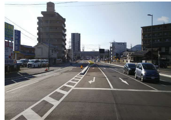
整備後の（都）熊本駅城山線
