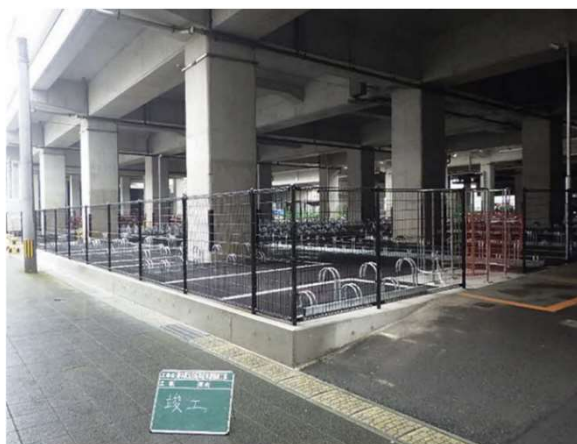
整備後の熊本駅北自転車駐輪場
