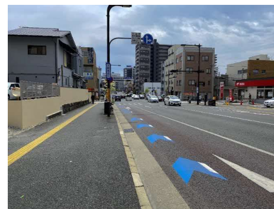
矢羽根型路面標示等の設置
