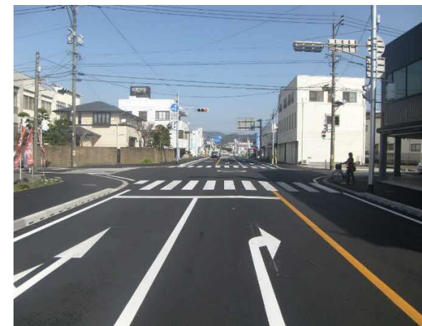
国道266号（松橋交差点）の改良
