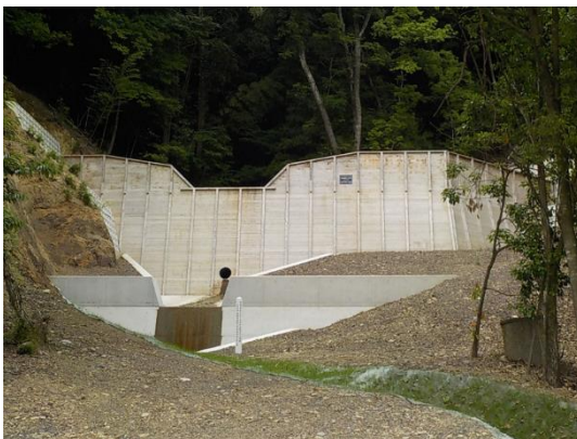
溪間工（谷止工）
