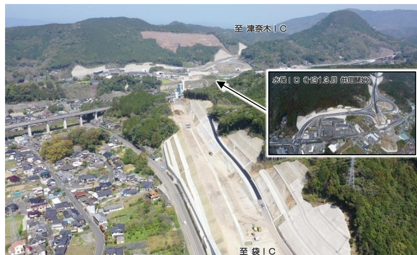
<南九州西回り自動車道整備>
