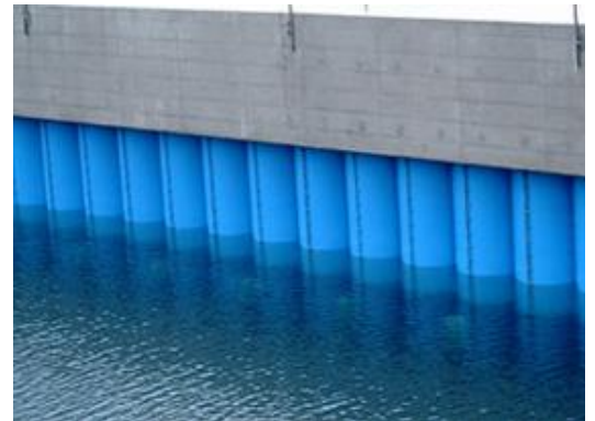
機能保全工事の実施 【竣工】
