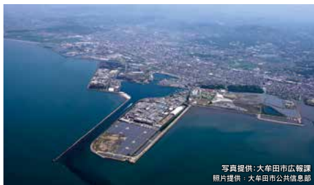
三池港 今も現役で稼働する三池炭の積出港 【所在地】福岡県大牟田市新港町 【連絡先】0944-41-2515 (大牟田市世界遺産・文化財室)
