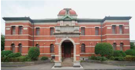
写真提供: 日本製鉄㈱ 九州製鉄所 Photo credit: Kyushu works, Nippon Steel Corporation
