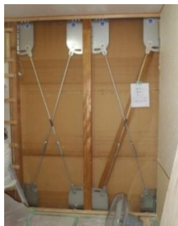
耐震改修工事例
