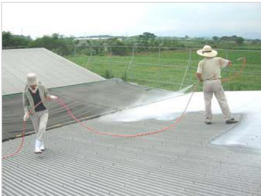
・石灰の吹きつけ
