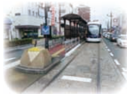
路面電車の停留所バリアフリー化
