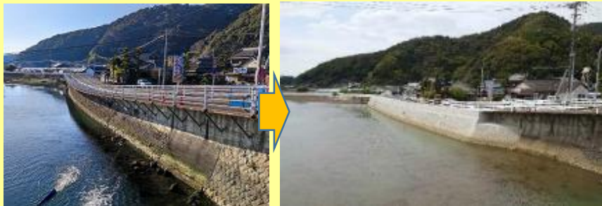
佐敷川改良復旧工事
