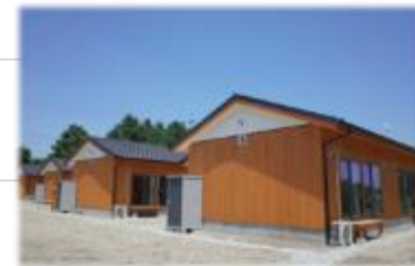
木造仮設住宅利活用等支援
