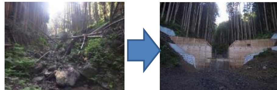
治山工事による荒廃溪流復旧状況(坂本町百済来下)
