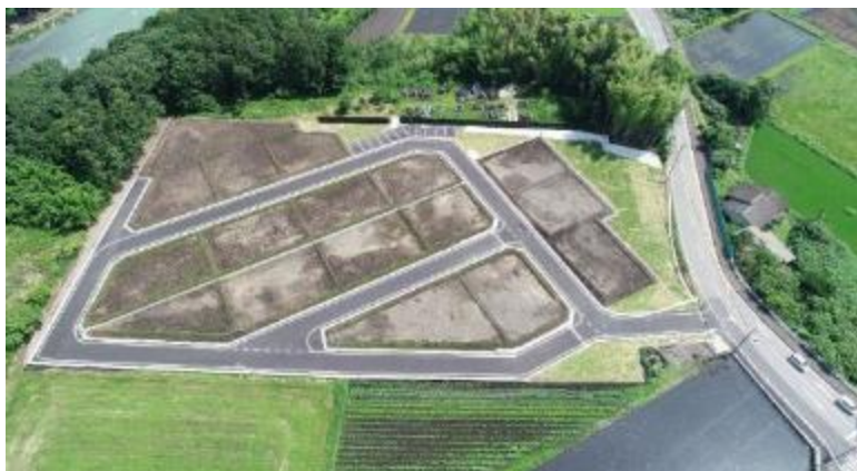
<並木野地区の分譲地>
