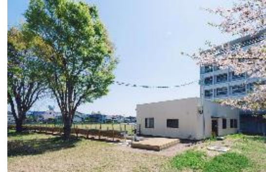
学内に整備した実験棟と実験水路
