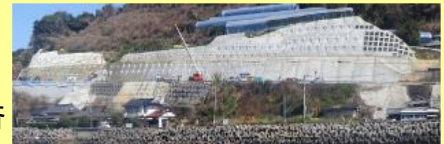
地すべり対策工事(津奈木町福浦)R5.3完了 → R5.4.11付解除
