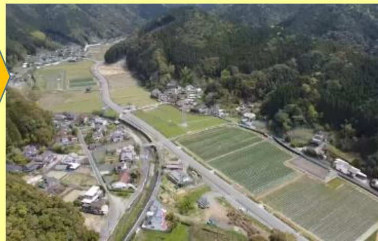
土砂災害復旧及びほ場整備(芦北町宮浦地区)
