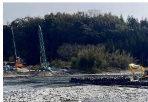
「球磨川第4橋梁」建設工事状況
