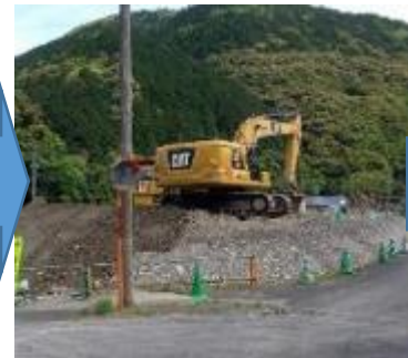
施工状況 (R5.5.12)
