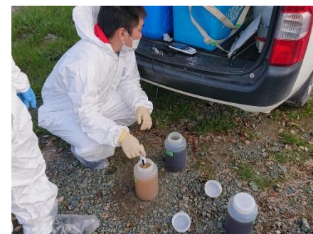
浄化処理状況の確認
