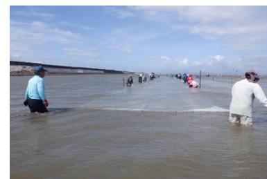
被覆網の設置
