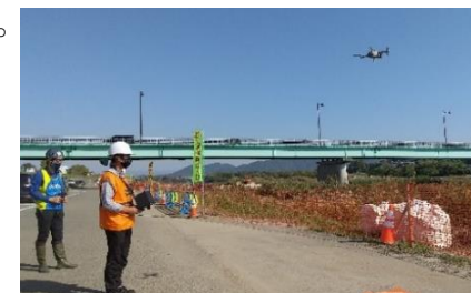
ドローンによる調査(玉名市、和水町)
