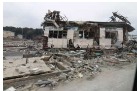
東日本大震災 岩手県山田町の被災状況 出典：東北地方整備局 災害伝承館 /所有者：山田町
