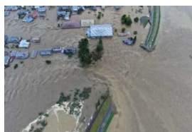
令和元年東日本台風 千曲川堤防決壊 出典：“猪（しし）の満水”（令和元年東日本台風）災害デジタルアーカイブ/提供者：千曲川河川事務所
