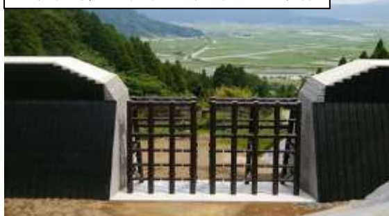
盤名木川第2砂防堰堤((阿蘇市)R4.6完成)
