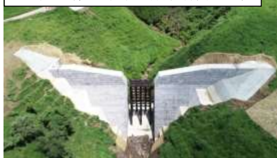
三王谷川1第3砂防堰堤((南阿蘇村)R4.7完)
