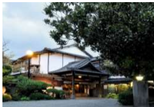
写真：温泉旅館の復旧状況
