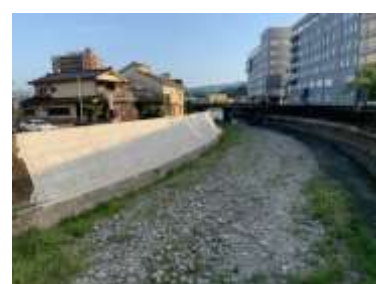
復旧状況（令和4年6月完了）
