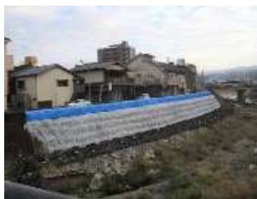
応急状況（令和3年5月時点）
