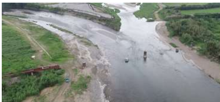
写真:「球磨川第4橋梁」付近(空撮)(流失した橋桁・橋脚等は撤去済み)
