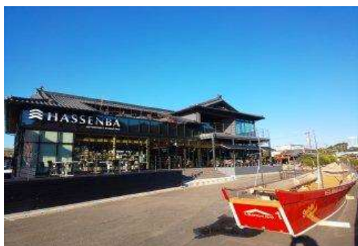
写真：観光複合施設の復旧状況
