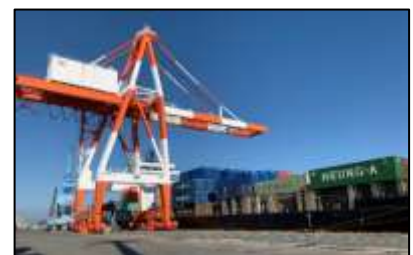
【コンテナ荷役状況】
