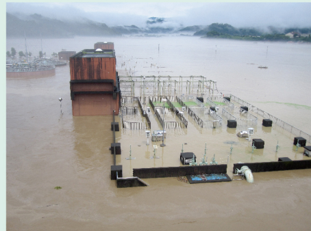
令和2年7月豪雨で浸水した下水処理場(人吉市)
