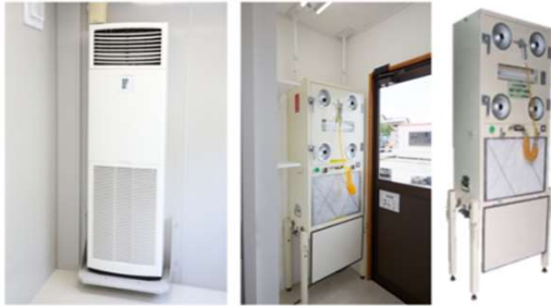
(左) エアコン (3馬力)、(右) 抗ウイルスHEPAフィルター内蔵エアシャワー (5.0坪タイプのみオプション)
